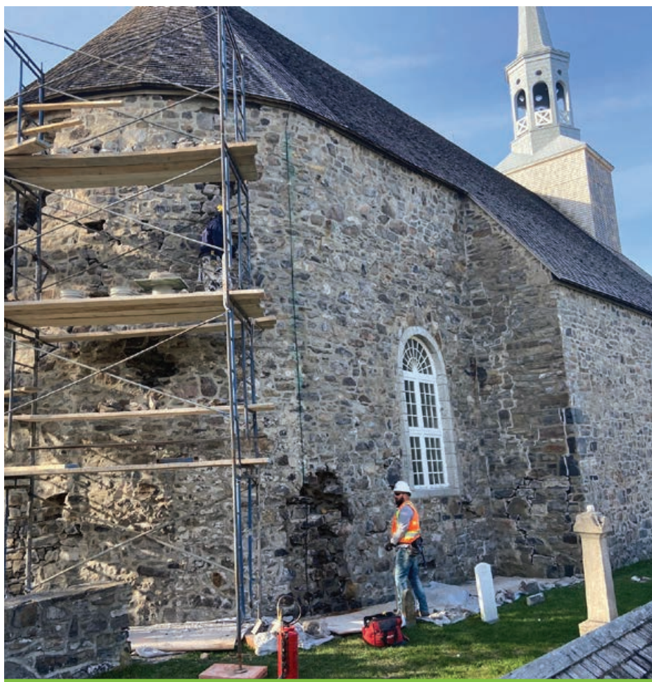
Les travaux de maçonnerie ont été réalisés à l'ensemble des murs de l'église de Saint-François.
