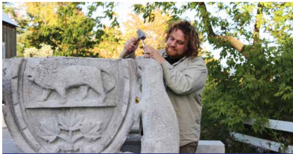
Adrien Bobin a utilisé du calcaire pour la réfection d'ornementations de l'hôtel du Parlement du Québec.
