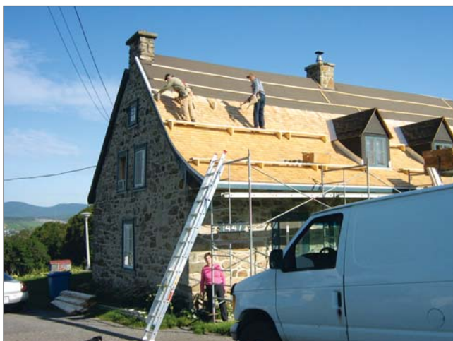
PENDANT LES TRAVAUX
